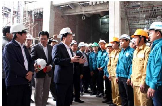
Bộ trưởng Trịnh Đình Dũng chúc Tết các kỹ sư và công nhân trên công trường xây dựng Nhà Quốc hội vào sáng ngày mừng 2 Tết Giáp Ngọ
